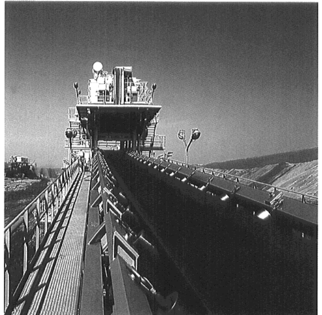
Gurtförderanlage mit absenkba- ren Girlandentragrollen im rheinischen Braunkohlerevier
